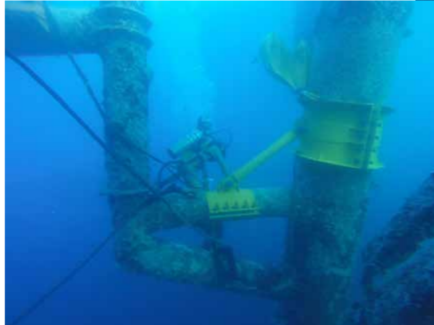
جزئیاتی نزدیک‌تر از عملیات تقویت سازه پهلوگیری سکو PLQ میدان بلال
