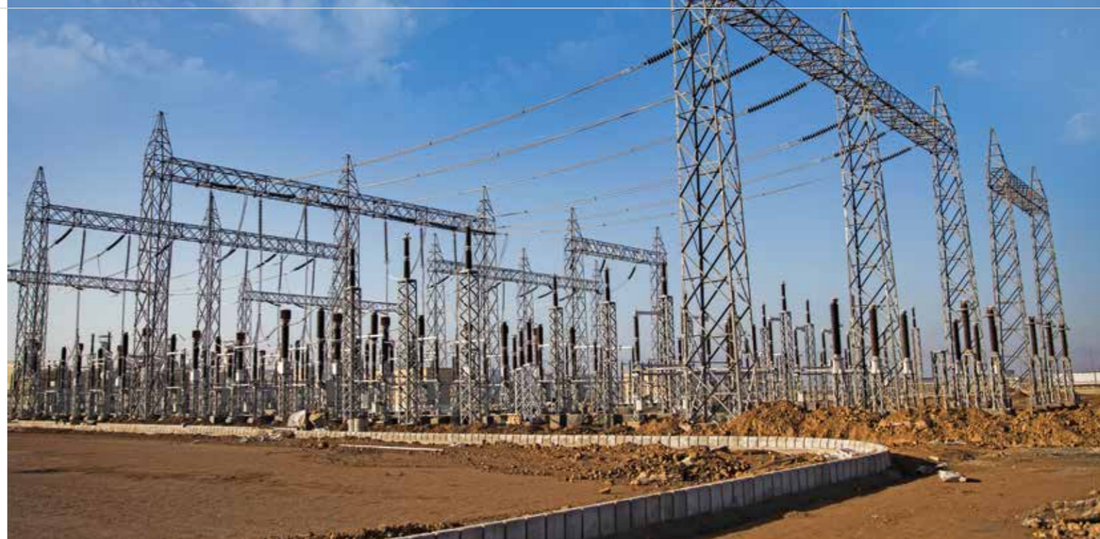
سرپرست طرح احداث نیروگاه غرب کارون اعلام کرد:
